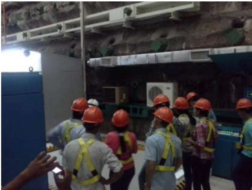
Casa de Máquinas, Hidroeléctrica la Fortuna
