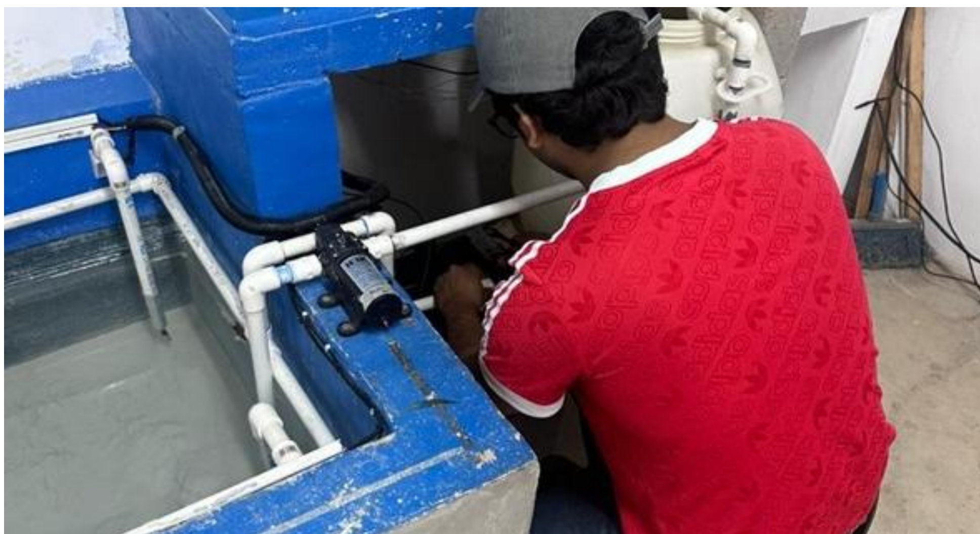
Instalación del sistema de enfriamiento y recirculación de agua.
