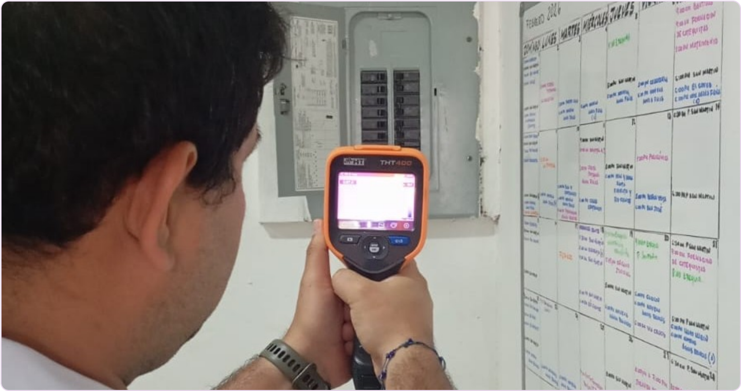
Medición de temperatura con cámara térmica.
